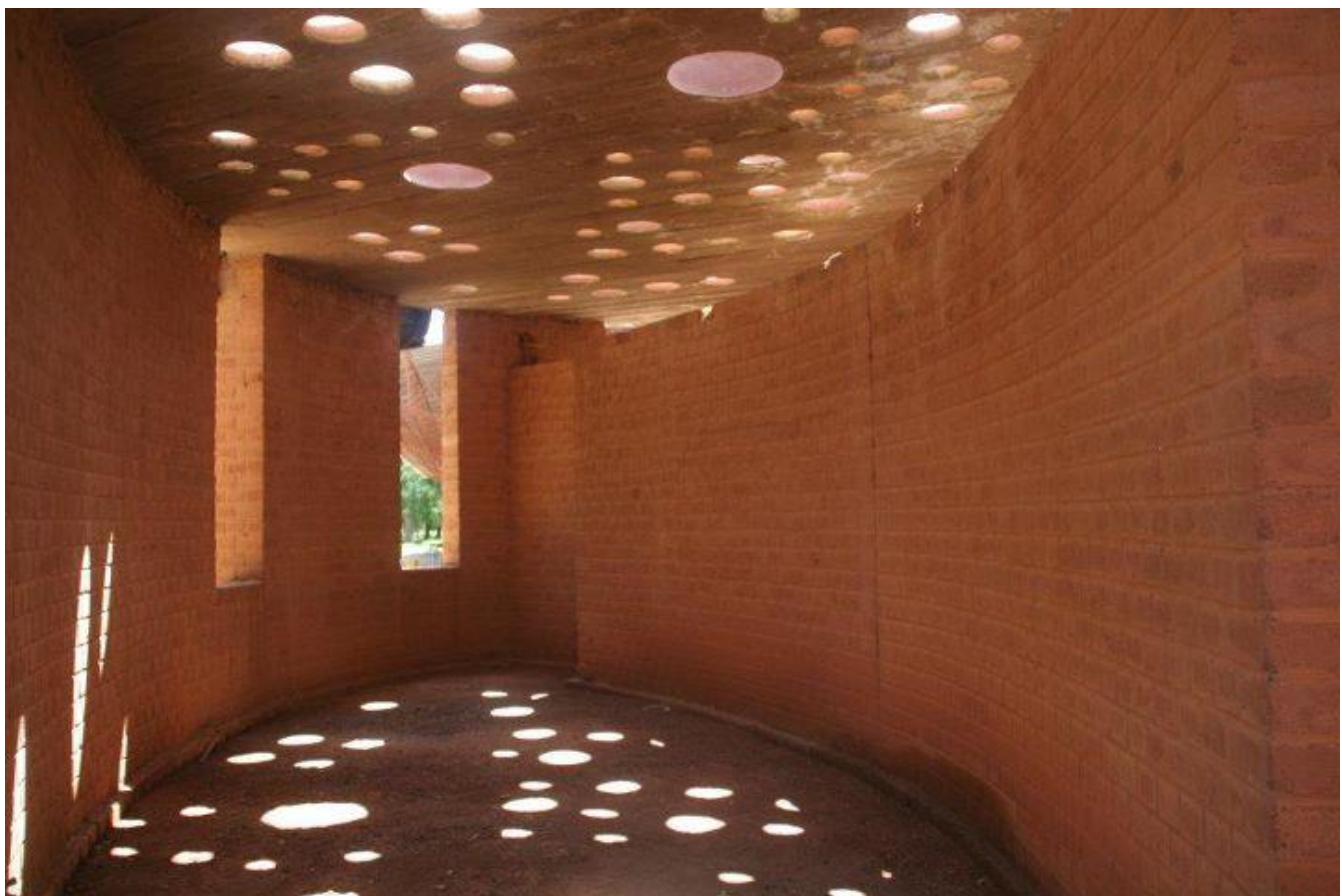
12. Die Unterdecke ist fertig. Die Tontöpfe in der Decke der Bibliothek lassen Licht und Luft in den Raum.
