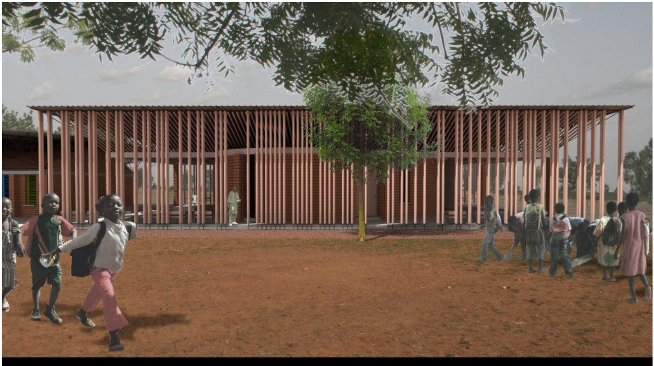
9. Auf dieser 3D Visualisierung sieht man sehr gut das ausladende Dach der Bibliothek. Es schafft schattigen Raum für die Kinder und schützt das Lehmgebäude vor Regen.
