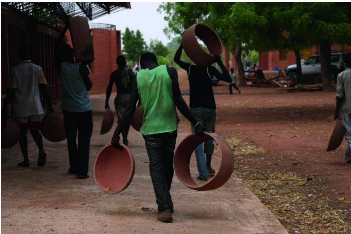
6. Benjamin bringt die geschnittenen Tontöpfe für das Dach auf die Baustelle der Bibliothek.
