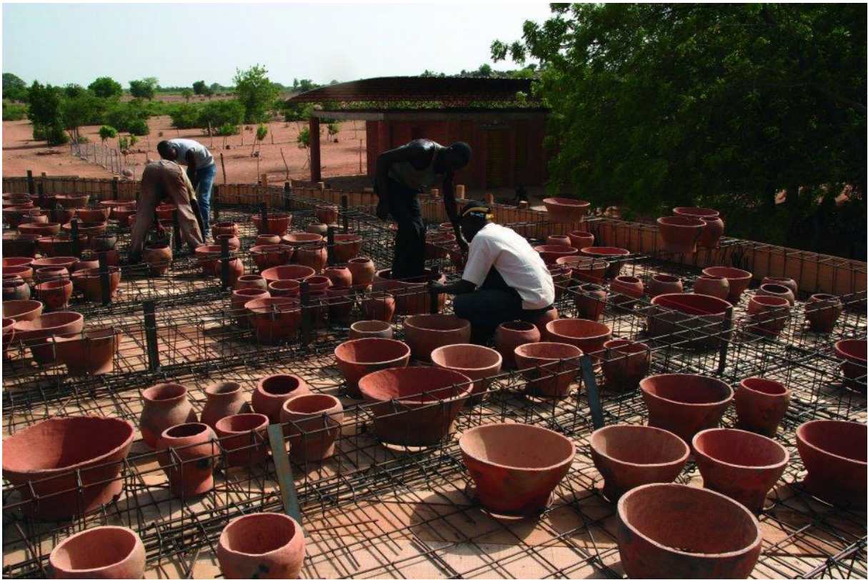
7. Die Arbeiten auf dem Dach der Bibliothek gehen voran. Die Tontöpfe sind ausgeschnitten und werden jetzt an den richtigen Plätzen auf der Holzschalung positioniert.
